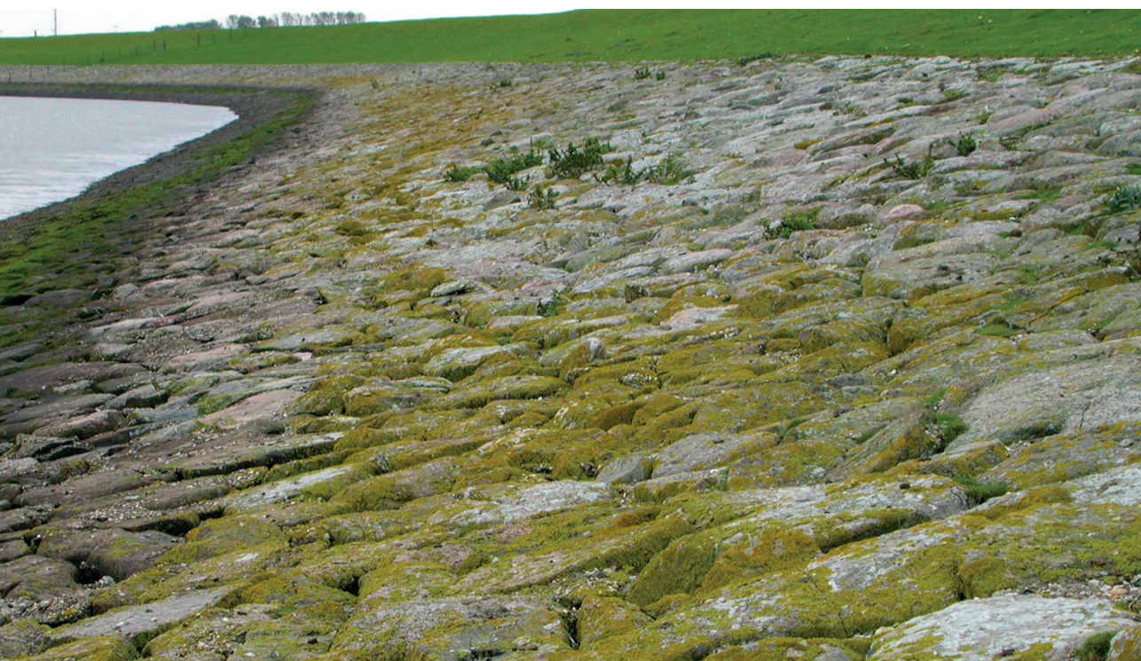
Figuur 5a. De dijk ter hoogte van Bierum in 2005 voor de werkzaamheden. Boven de Noorse steen ligt gras begraasd met schapen (foto Laurens Sparrius).
