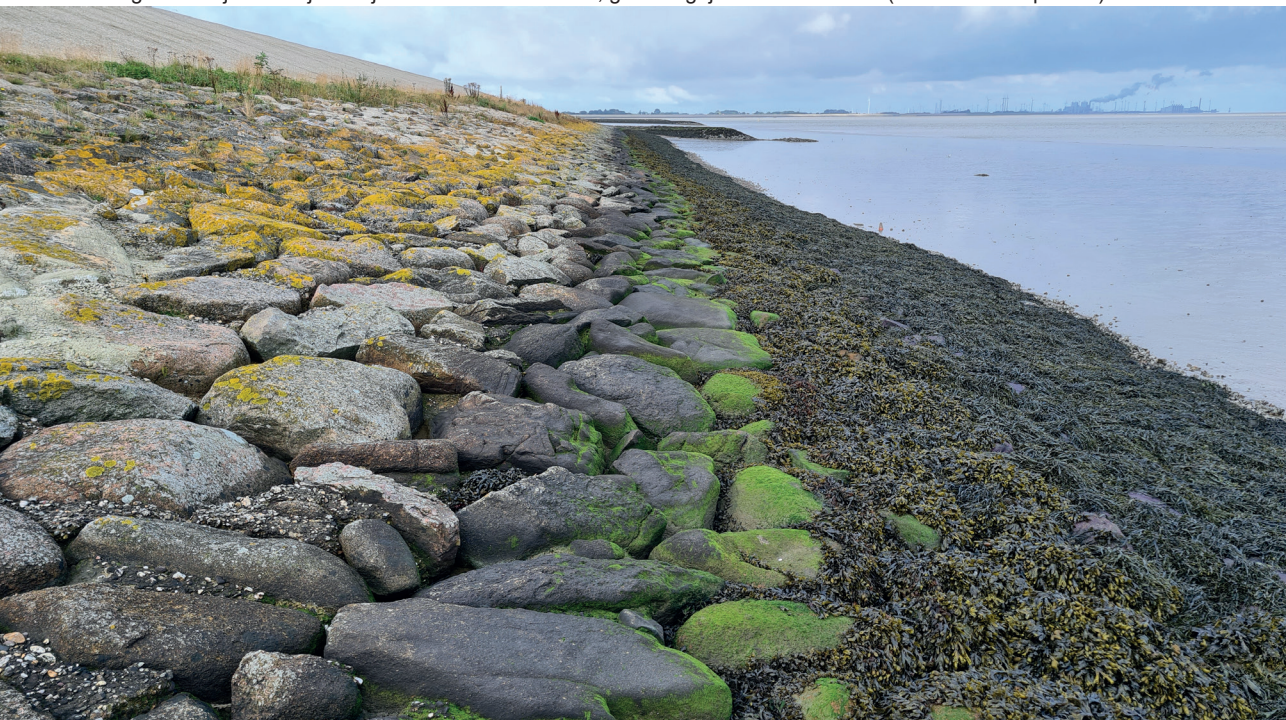
Figuur 1. Dijktaalud bij Delfzijl in 2021 met de zwarte, gele en grijze zone zichtbaar (foto Laurens Sparrius).
