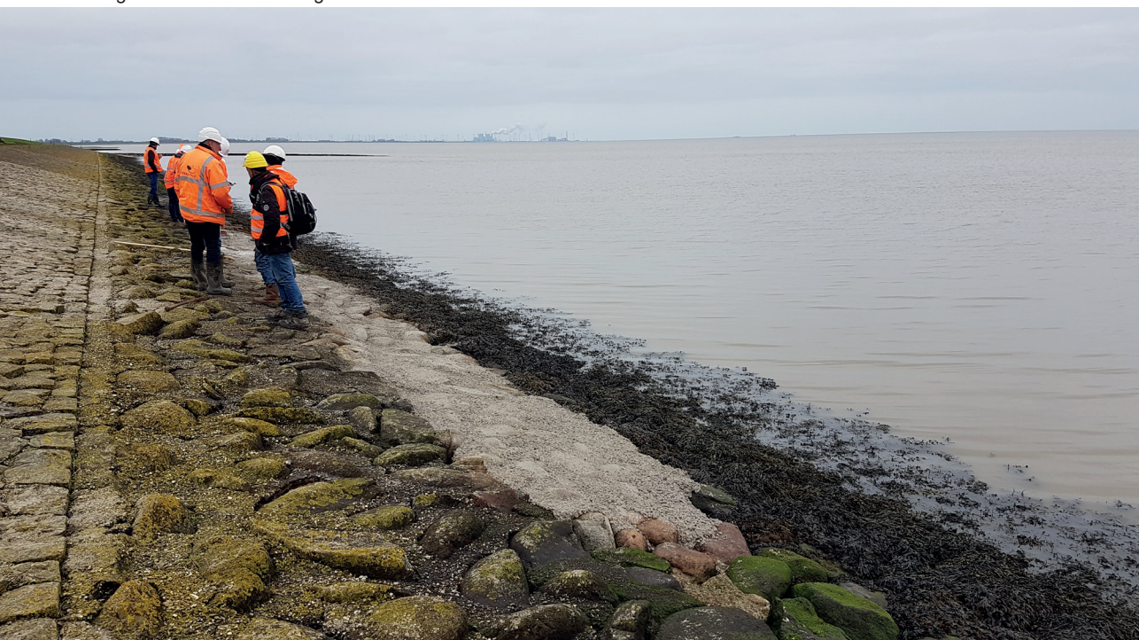
Figuur 3. Proef met het ingieten van Noorse steen met beton in december 2017.
