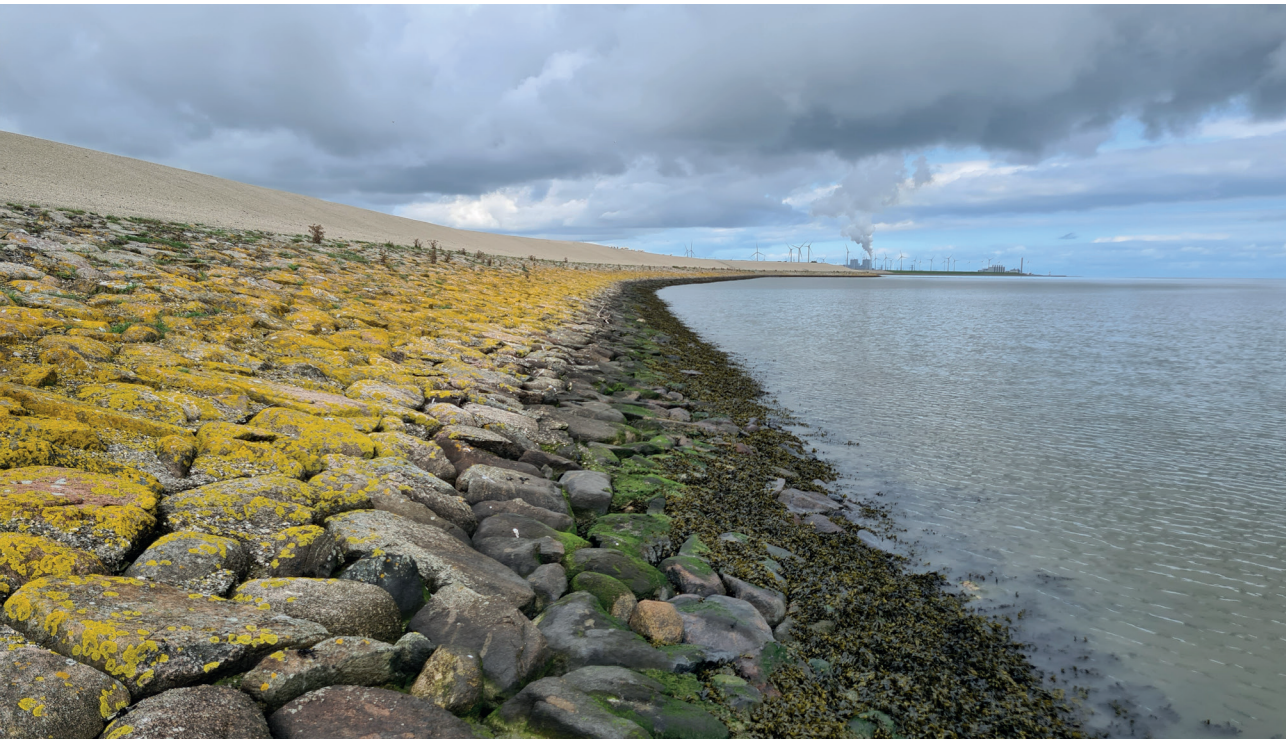
Figuur 5b. De dijk na de dijkverzwaring in 2021 met asfalt boven de Noorse steen. Op de achtergrond is de Eemshaven zichtbaar (foto Laurens Sparrius).
